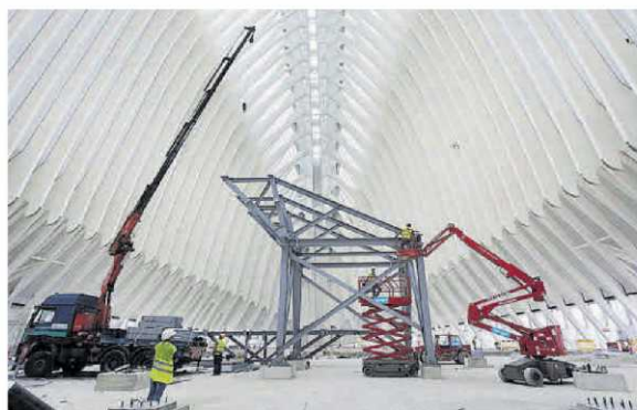
Trabajos en el interior del Àgora.
