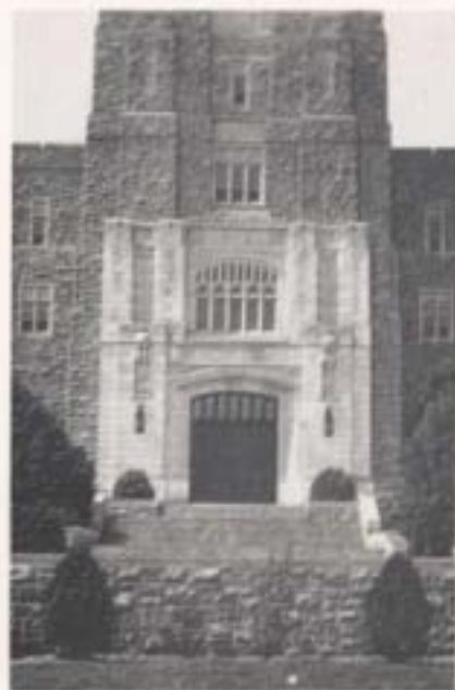
T. & A. Building
