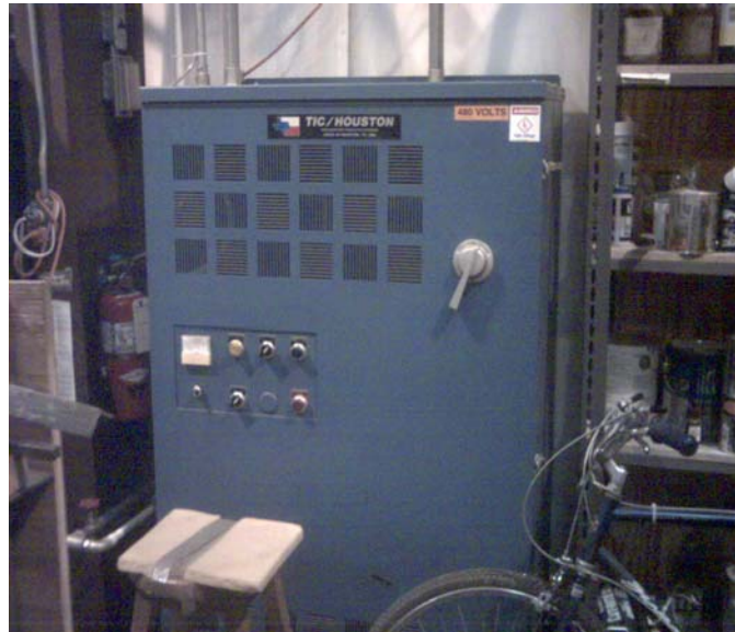
Fig. 6 Motor breaker
