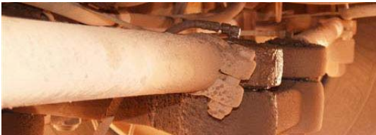
Figure 4.15 - Actual Tie Rods
