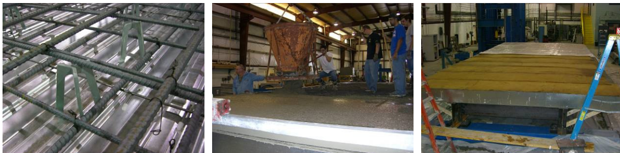
Figure 3.11: Concrete deck pour details (a) Rebar placement (b) deck pour (c) deck moist curing
