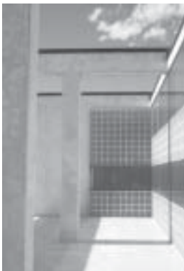
Casa del Fascio, Roof
