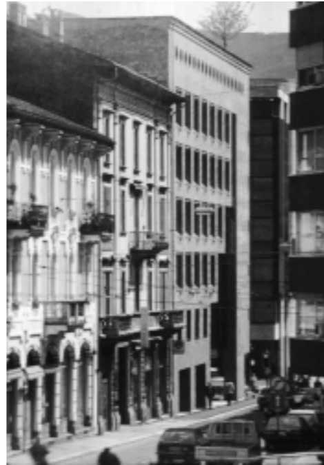
24 Societa Banca Svizzera from side street
