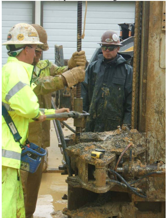
(d) connecting the steel bars
