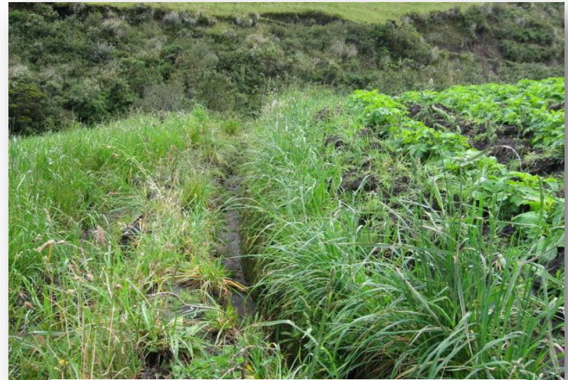
Zanjas de desviación de agua
