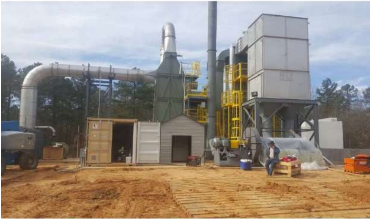
PAS System Construction
