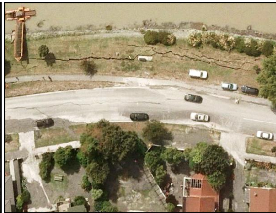
(d) Severe Lateral Spreading
