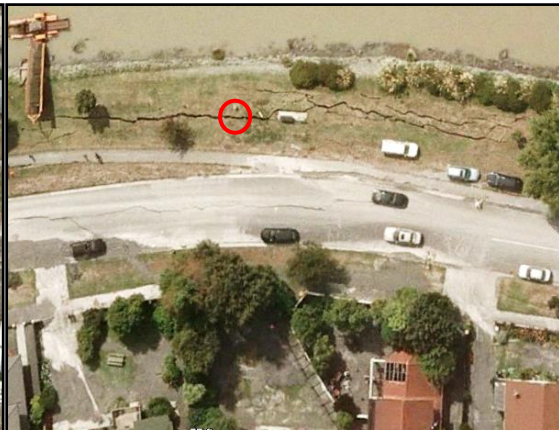
(d) Severe Lateral Spreading
