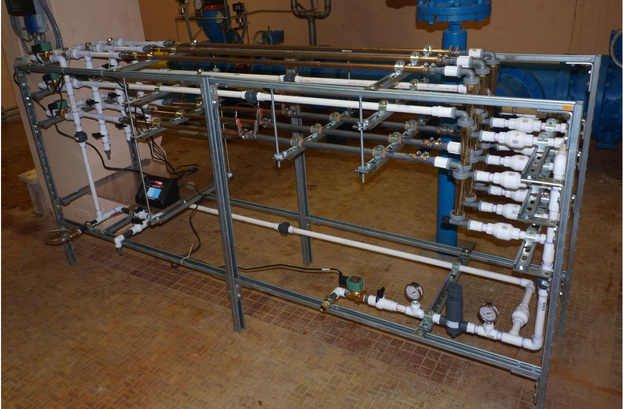
Fig E2 Corrosion evaluation rig.
