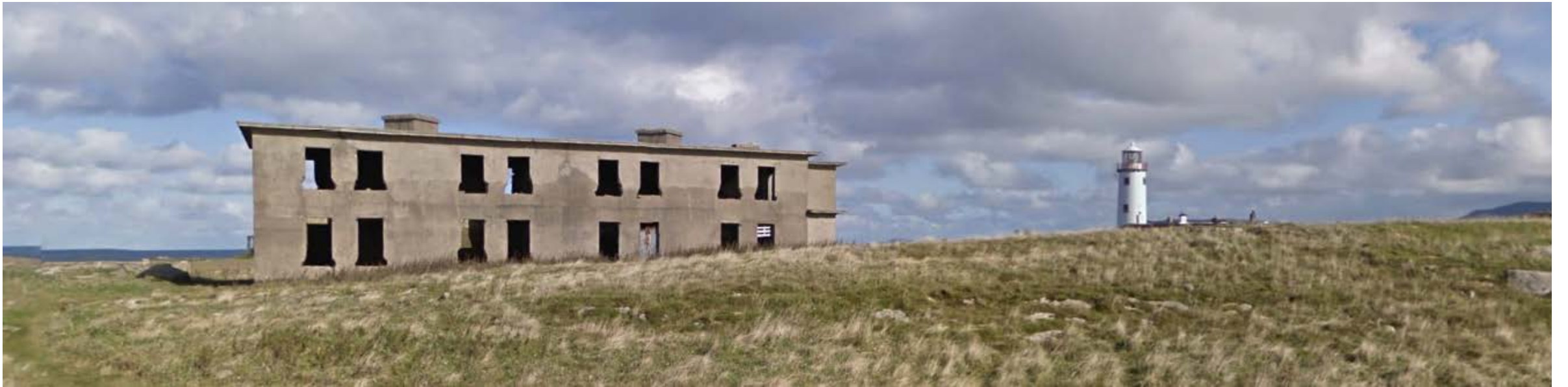
Site Photo [Fig. 2.]
