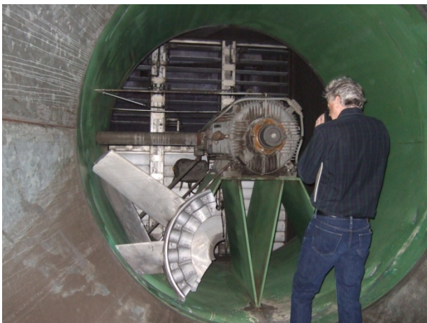
Fig. 1. Fan blade penetrating casing for horizontal fan failure.
