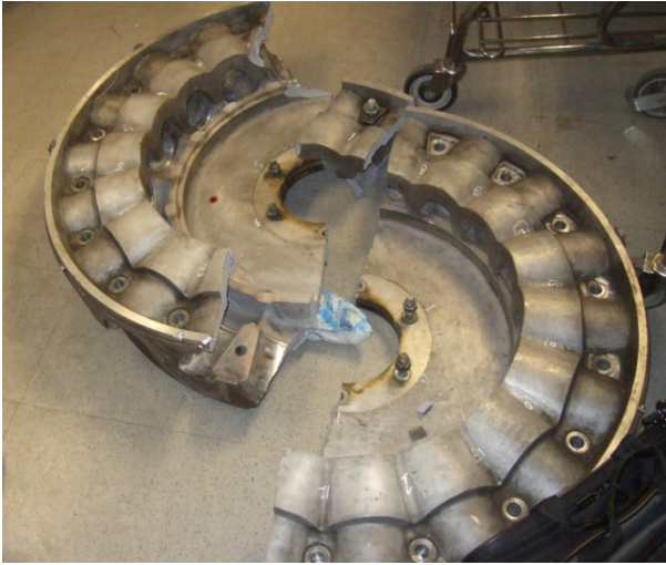
Fig. 3. Vertical fan no. 2 fractured fan hub.
