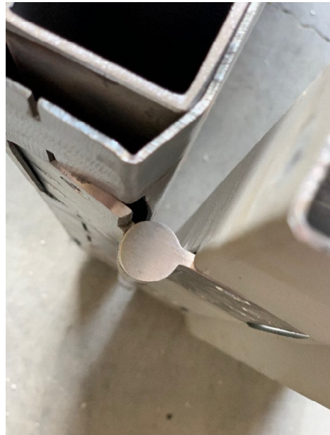
(d) Series 9A deformed hinge plates and deformation in door-skin.
