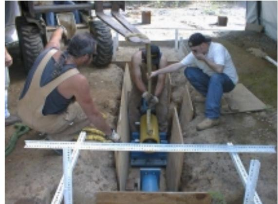
(d) Installing hydraulic ram in loading trench.
