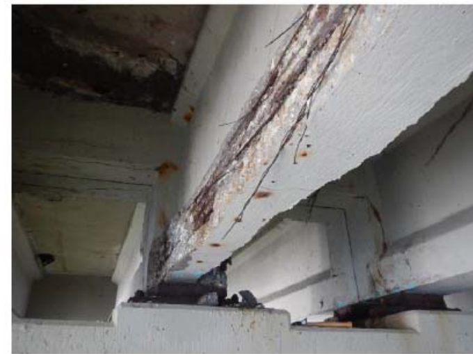
PHOTO P (BEAM 4, SPAN 34)
