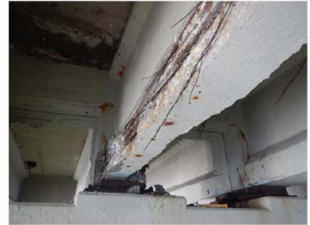
PHOTO N (BEAM 4, SPAN 34)
