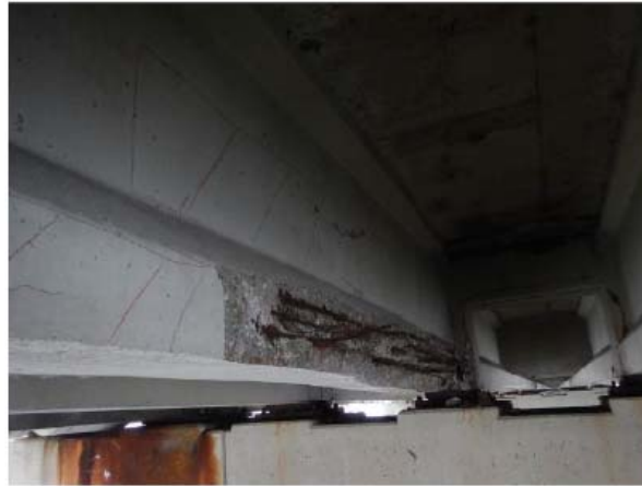
PHOTO M (BEAM 4, SPAN 34)
